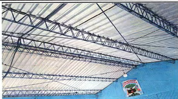
Foto 2: PARTE INTERIOR TECHO (MODULO 1)
