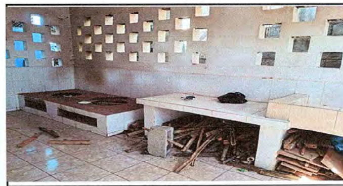
Foto 6: PARTE INTERIOR (MODULO 3)
