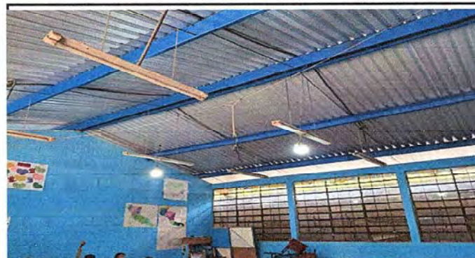
Foto 4: PARTE INTERIOR TECHO (MODULO 2)
