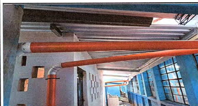
Foto 5: PARTE EXTERIOR (MODULO 3)
