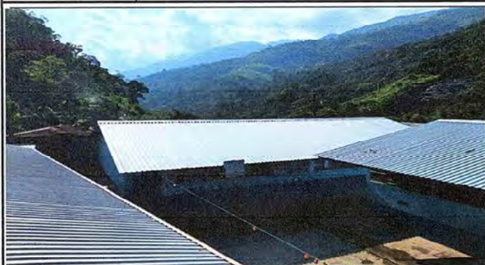
Foto1: PARTE EXTERIOR TECHO (MODULO 1)
